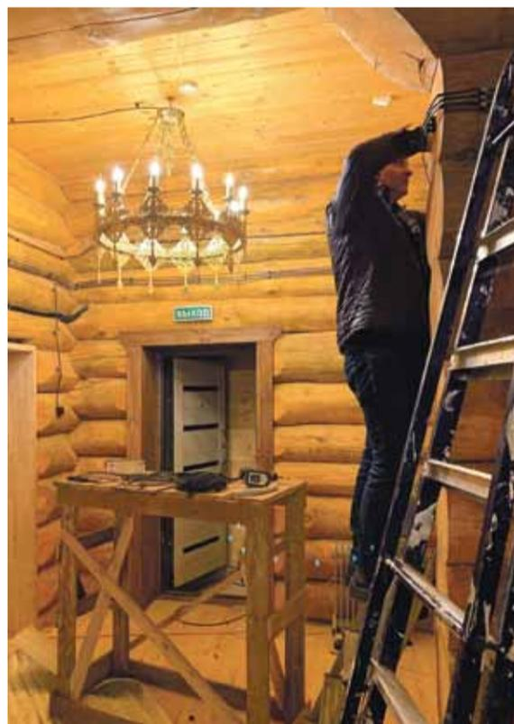
Бригада электриков ВМЗ смонтировала внутреннюю электрическую сеть и установила люстры и бра
